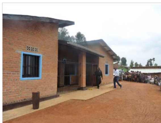
Построенная кухня в лагере
